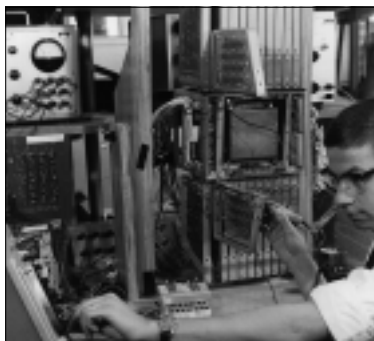
Oscilloskopet var det viktigaste och nästan enda hjälpmedlet vid felsökning på 60-talet. Sören Mohlin kör in minnesenheten i en D21:a.
